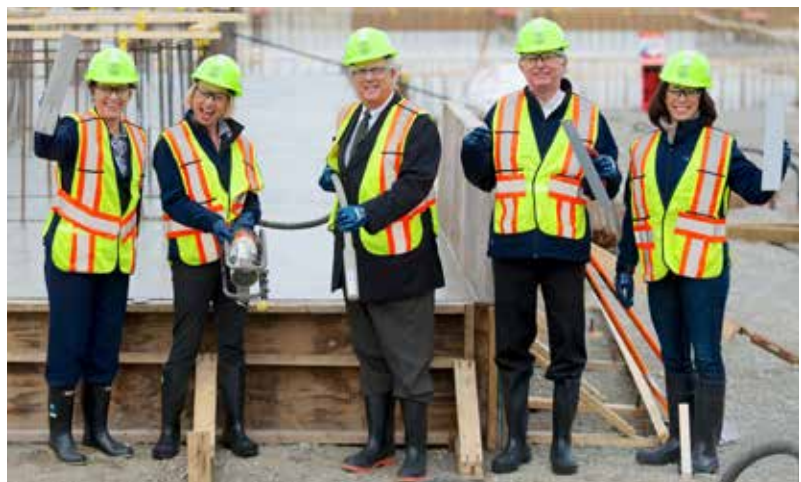
Concrete pour for Minoru Centre for Active Living
